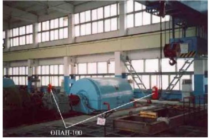
Автоматическая система противопожарной защиты компрессорного цеха завода "Пермнефтегазпереработка" (г. Пермь)
