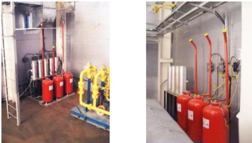
**Рис. 2.** Комбинированная установка КУП “аэрозоль + порошок” ГПА 66ГЦ-1162 АО “СибурТюменьГаз”, расположенная в свободных зонах укрытия объемом 3860 м<sup>3</sup>
