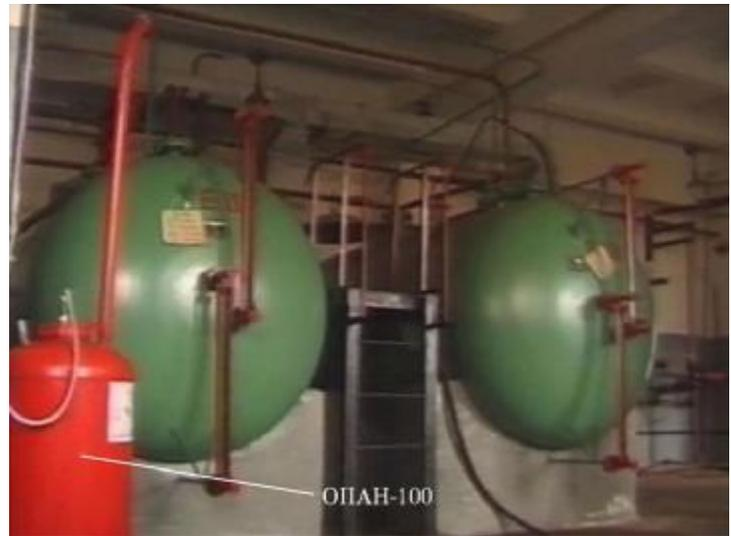
Система пожаровзрывозащиты маслохозяйства газоконпрессорного цеха на заводе "Пермнефтегазпереработка" (г. Пермь)
