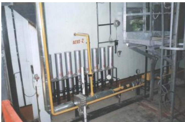
**Рис. 3.** Кассетная схема размещения ГОА АГАТ-2А-180
